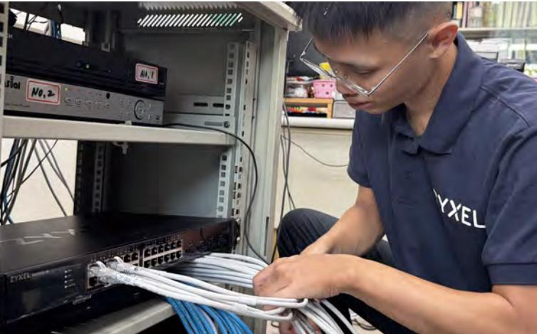
為了擴展建築內的連線與電源，四台GS1915-8EP PoE交換器被安裝到位。透過將無線基地台重新導向這些位置，Zyxel團隊簡化了無線系統的管理，並消除獨立電源的需求。十二台NWA50AX無線基地台在四層樓設施中上線，提供建築每個角落快速、無縫且大幅改善的無線覆蓋。
